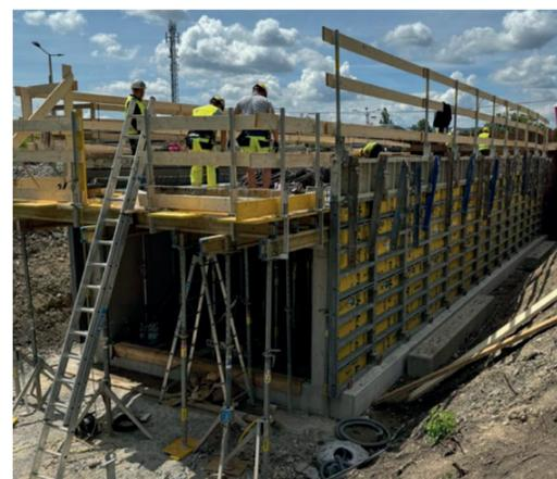
Am 23. Mai – zum Zeitpunkt der Erstellung dieses Beitrags – waren Bodenplatte und Seitenwände bereits fertig und die Bewehrung für die Deckplatte wurde eingebracht. Eine besondere Herausforderung ist, die erforderliche Höhe des Tunnelprofil zwischen Straßenoberfläche und der Überfuhr des kleinen Krotenbachs unterzubringen – die Konstruktion muss letztendlich Fahrzeuge bis max. 44 t und Achslasten bis max. 11,5 t sicher aufnehmen können.
