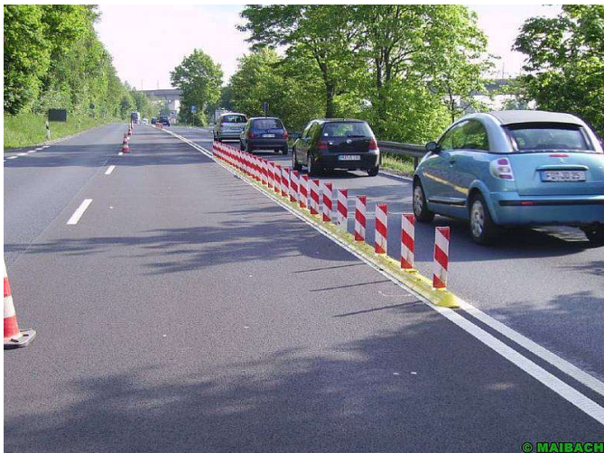
Abbildung 3 Beispiel Leitschwelle mit Minibaken
